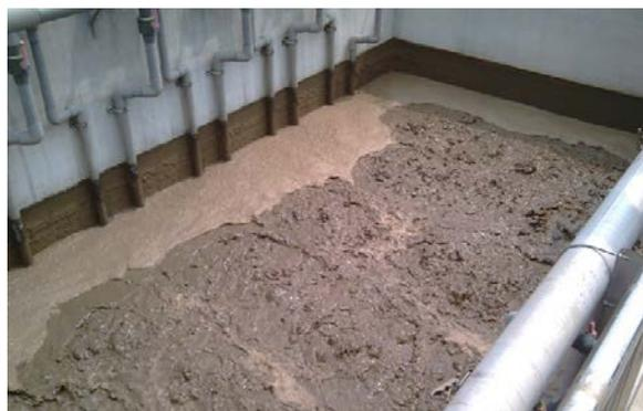
圖-5 MBR 生物池的污泥系統
